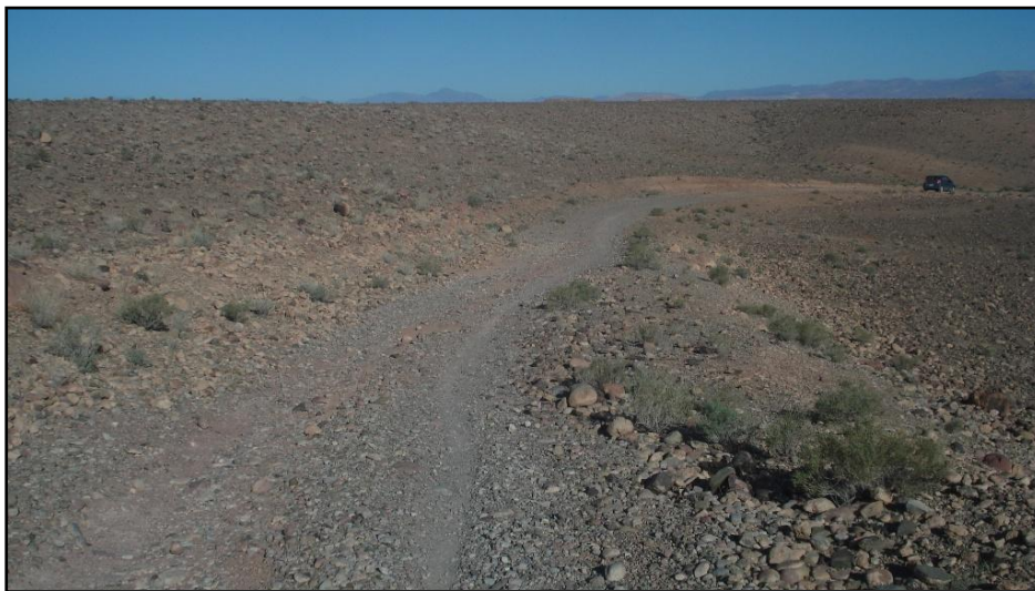
Photo 19 : Sous-tronçon 1 de la route de déviation
