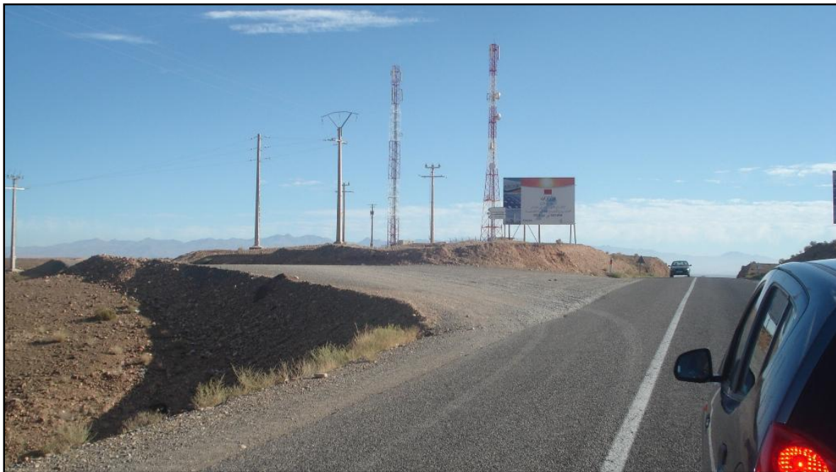
Photo 1 : Point de jonction RN10 et piste d'accès au site du complexe énergétique solaire de Ouarzazate
