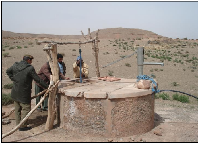
Photo 7 : Douar Essour - Puits artisanal équipé d'une pompe manuelle à 2.7 km au Nord Est du site du complexe solaire de Ouarzazate
