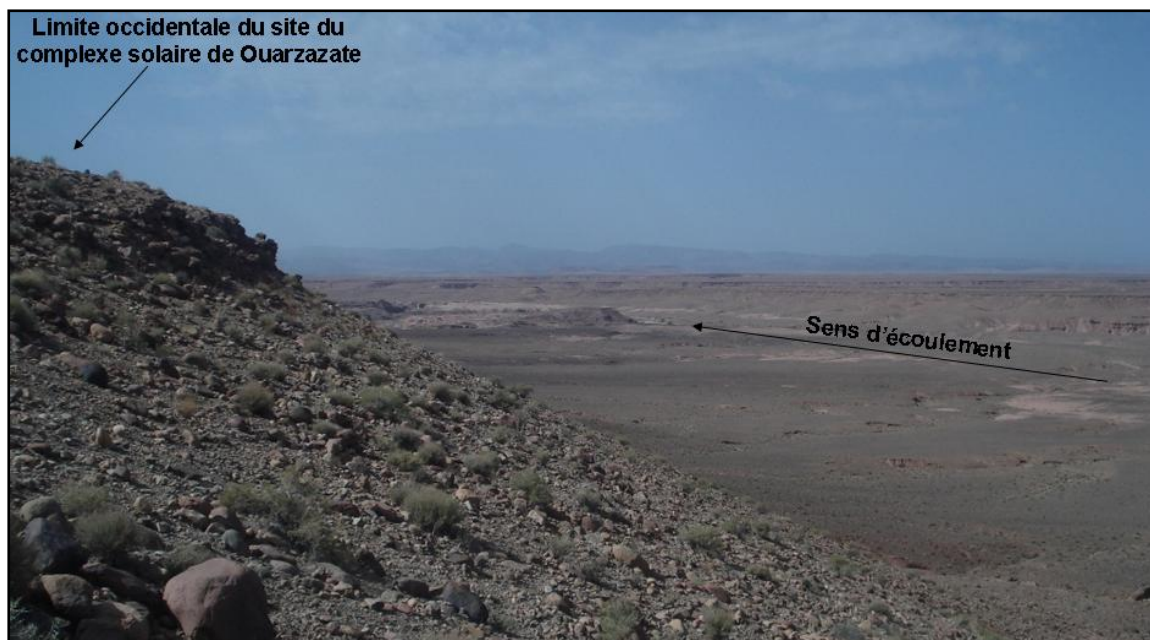
Photo 12 : Vue sur l'oued Wargouine à partir de la bordure occidentale du complexe énergétique solaire de Ouarzazate
