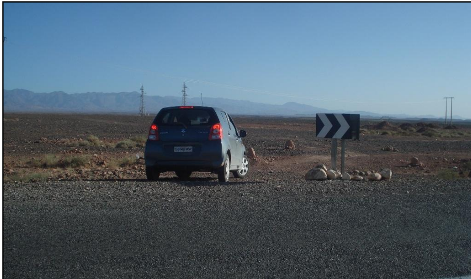
Photo 18 : Début du tracé de la route de déviation à partir de la RN10
