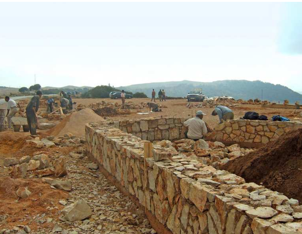
Travaux en cours dans le balcon d'Ito.
