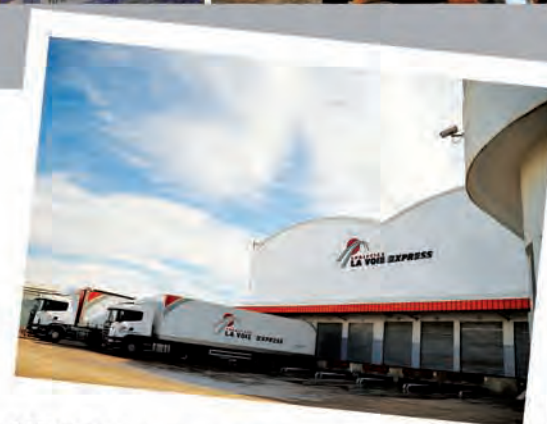
CASABLANCA - Site Ain Sebaâ : • 4 000 m 2 de surface entrepôt • 6 000 palettes de capacité de stockage • 10 portes de chargement et déchargement
