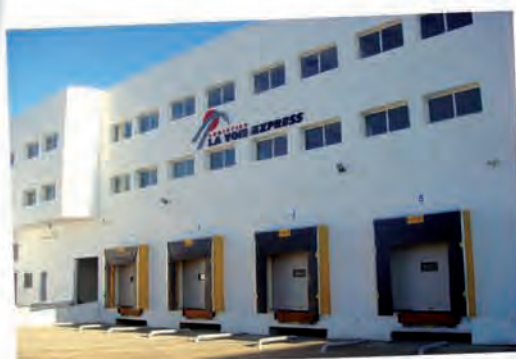
RABAT - Site Rabat Ain Atiq : • 5 000 m 2 de surface entrepôt • 7 000 palettes de capacité de stockage • 10 portes de chargement et déchargement
