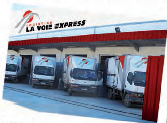
TANGER - Site Tanger centre : • 4 000 m 2 de surface entrepôt • 6 000 palettes de capacité de stockage • 7 portes de chargement et déchargement
