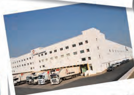
CASABLANCA - Site Casa sud : • 30 000 m 2 de surface entrepôt en module de 5 000 m 2 • 46 000 palettes de capacité de stockage • 66 portes de chargement et déchargement
